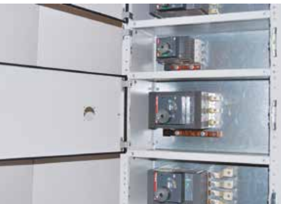
Die einzelnen Felder sind hier in FORM 4A ausgeführt. Diese Lösung ist besonders dort gut geeignet, wo ein Höchstmaß an Sicherheit gefordert wird.
