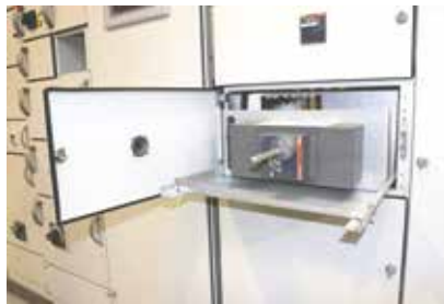
FORM 2-Abdeckung der Schienen sowohl senkrecht, oben als auch vor der Verbindung der Schienensysteme.
