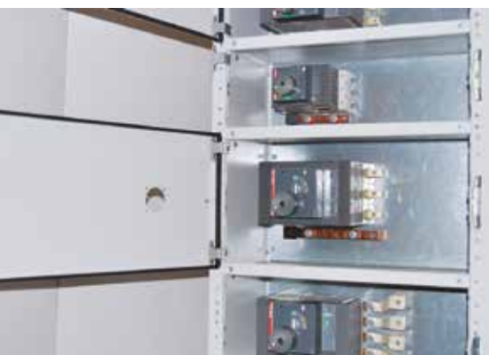
De enkelte felter er her udført i FORM 4A, som er særlig velegnet, hvor der ønskes en høj sikkerhed.
