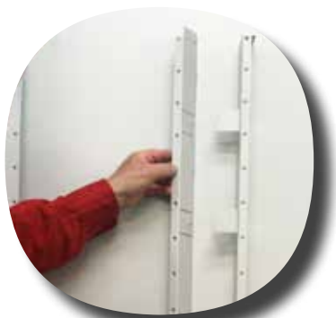
Profils de division montés (accessoires).
