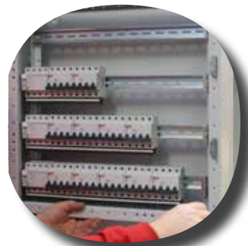
Les câbles et le cadre avant sont montés.
