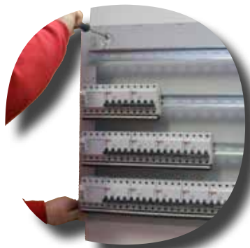
La plaque arrière est fixée au mur.
