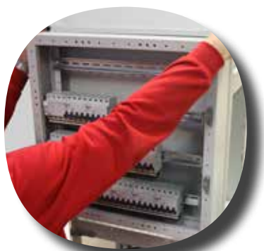
Les brides sont montées en haut et en bas.
