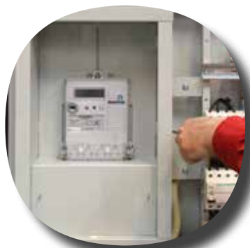
Le compartiment de compteur est monté (accessoire).
