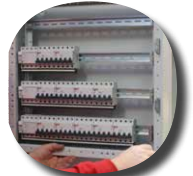
Kabler samt forramme monteres.
