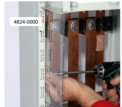
Sideafdækninger monteres i begge sider.
