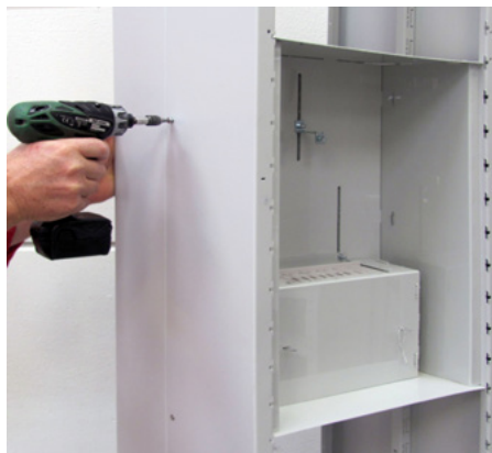
Sider til platformen skrues fast.
