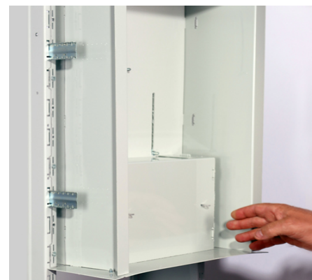
Afdækningen klipses ind over stagerne, hvor der efterfølgende kan plomberes.
