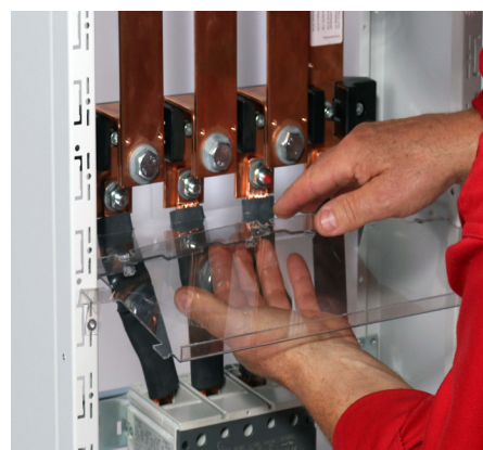
Sæt flige sammen på de 2 plader og skru afdækningen fast i platformen.
