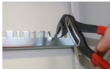
For nemmere montering af kabelbakke, bukes en tab ud i begge sider af kabelafastningen.
