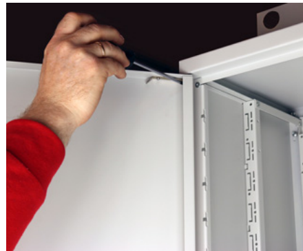
Hængslet vippes lidt ned for oven, inden lågen flyttes på plads.
