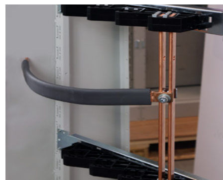
Montage af f.eks. Cu-flex på skinner.
