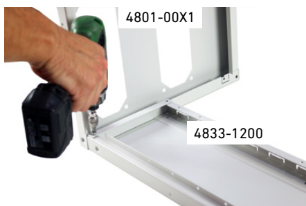
Top/bund skrues på platformsiderne.
