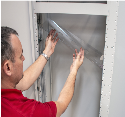
Sidestykker monteres med skrue i begge sider. Inderste top/bund monteres
