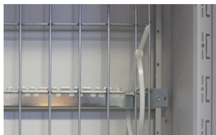
Kabelbakken monteres herefter med kabelbindere. Anvend 2 kabelbindere \geq 535Nm pr. kabeljern.
