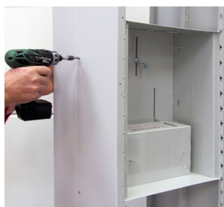
Sider til platformen skrues fast.
