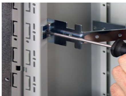
Beslag monteres i platformen.
