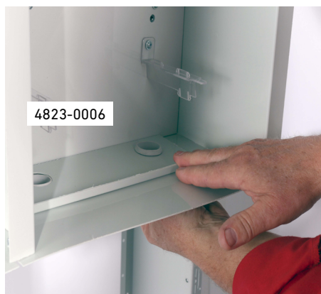
4823-0006 Støtteplade monteres - husk at membran skal igennem begge lag plast.
